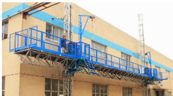
4. ábra. Kétoszlopos mozgóállvány mini darukkal
